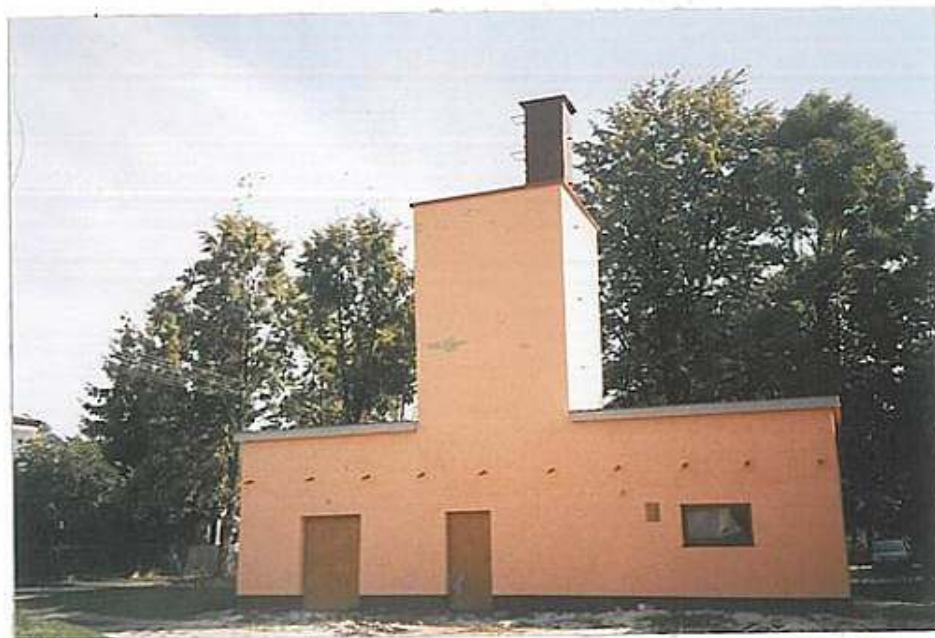
KOTŁOWNIA OCHOTNICZEJ STRAŻY POŻARNEJ W ŁOMAZACH PO PRZEPROWADZONYM REMONCIE.
