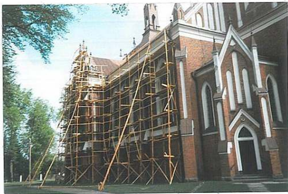
REMONT KOŚCIOŁA W ŁOMAZACH. STRONA POŁUDNIOWA.
