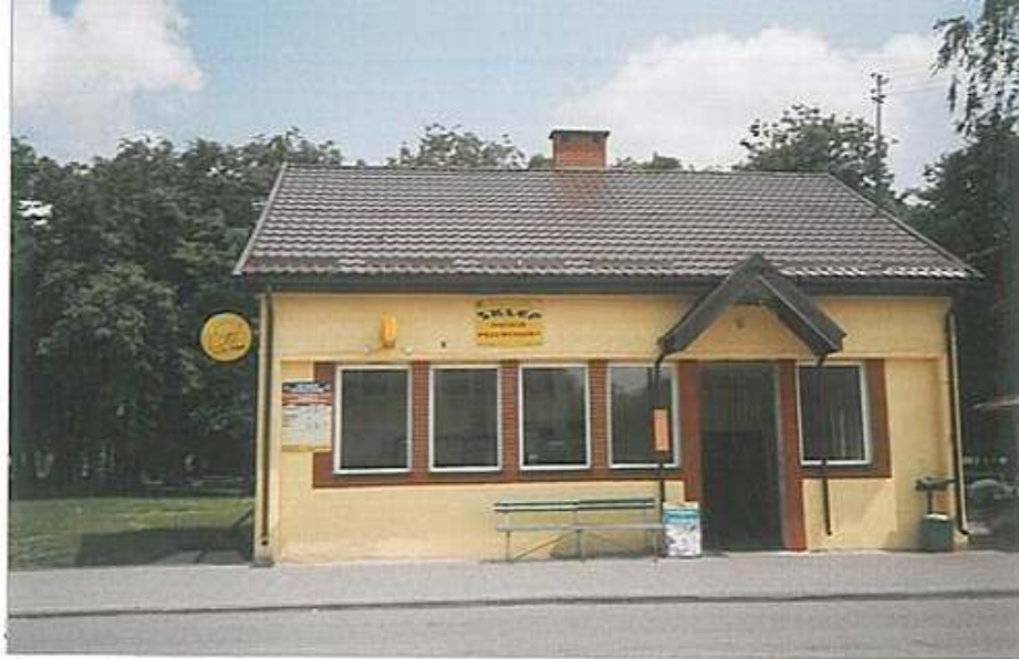
NOWE OKNA W BUDYNKU POCEKALNI PRZYSTANKU AUTOBUSOWEGO W ŁOMAZACH.
