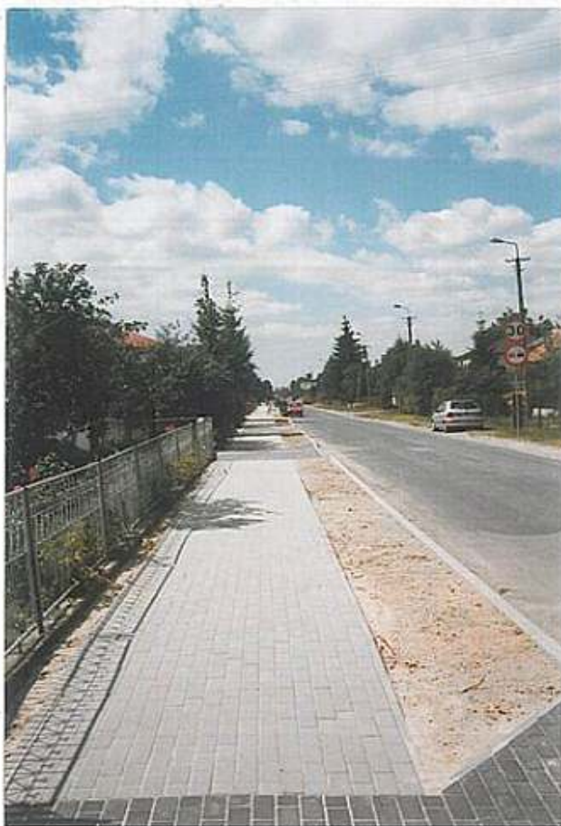
BUDOWA NOWEGO CHODNIKA NA ULICY LUBELSKIEJ W ŁOMAZACH.
