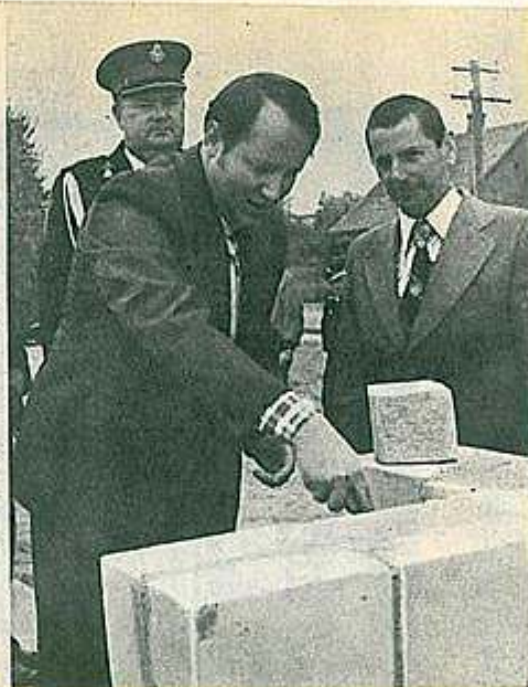
Wicewojewoda białkopodlaski, prezes ZW ZOSP W. Obszański wbudował akt erekcyjny budowy nowej strażnicy w Łomazach
