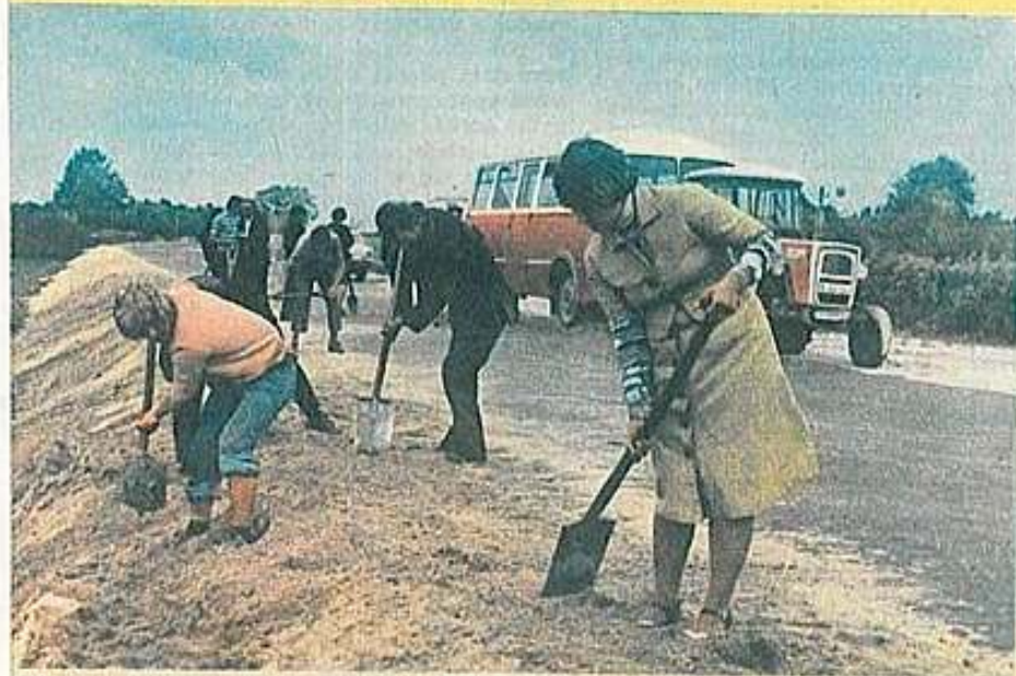
Calonkinie KDP przy budowie drogi w gminie Końsk
