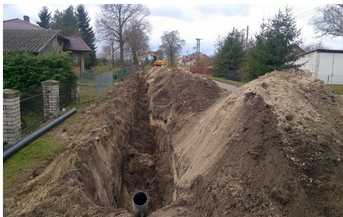
Budowa wodociągu w Korczówce
