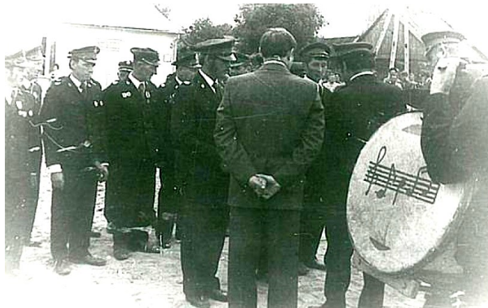
16 lipca 1978 - Odznaczenie przodujących strażaków podczas uroczystości wmurowania kamienia węgielnego pod budowę remizy
