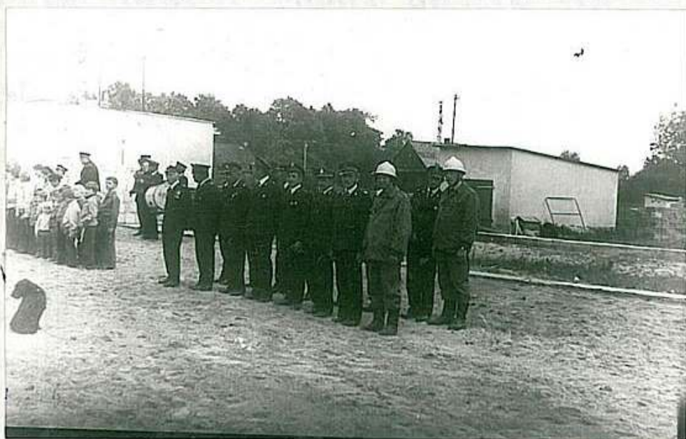
Strażacy DSP Łomazy na placu budowy. Widoczne fundamenty budowanego czynem społecznym Domu Strażaka.
