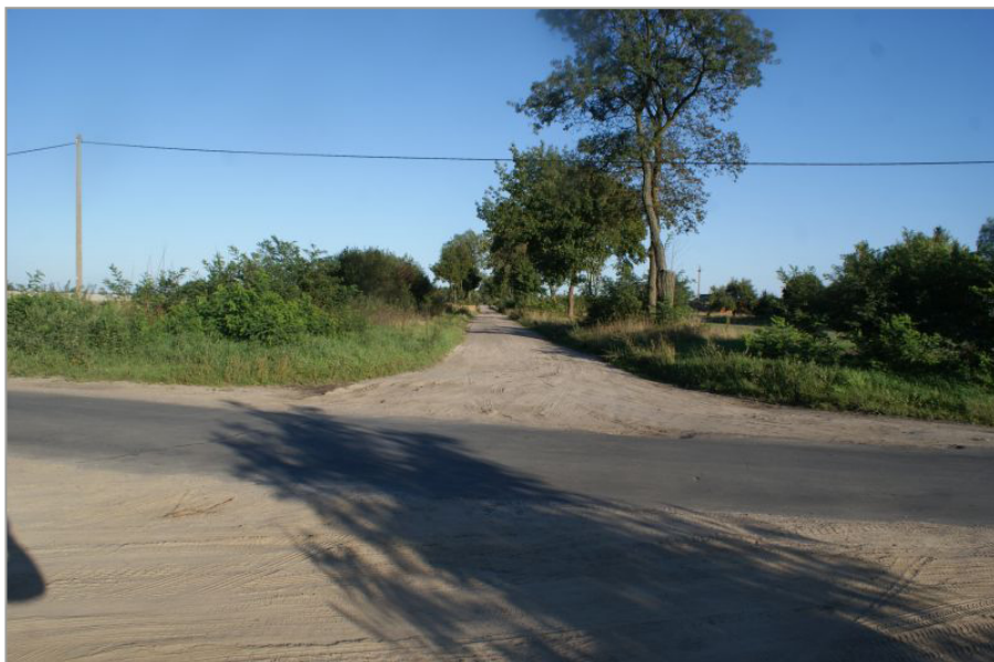
Droga Studzianka-Koszoły, Tędy pobiegnie nitka wodociągu do oddalonych o kilka kilometrów na wschód Koszoł.
